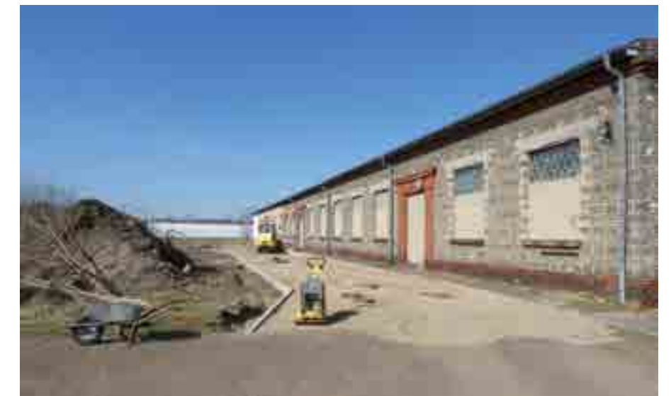
Bau eines neuen Weges im Industriehof © GuMS, Foto: Horst Seferens
